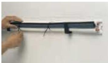
Pose du couvercle par simple clipsage
