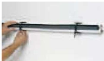
Pose du couvercle par simple clipsage
